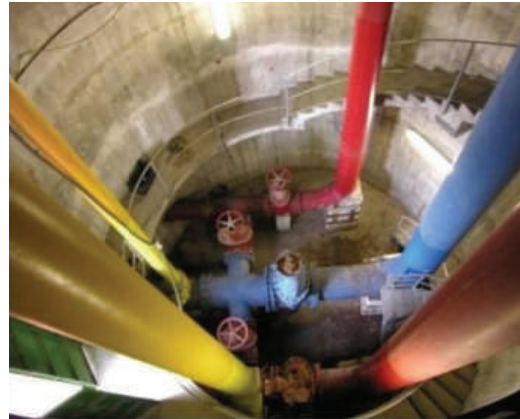
Сл.2.47.Сува комора, цевки, арматури и скали
