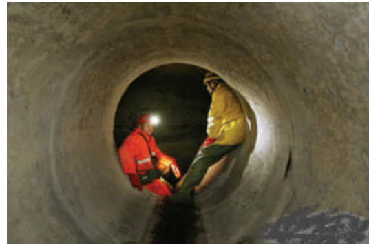
Сл.3.30.Чистачи на каналски цевки
