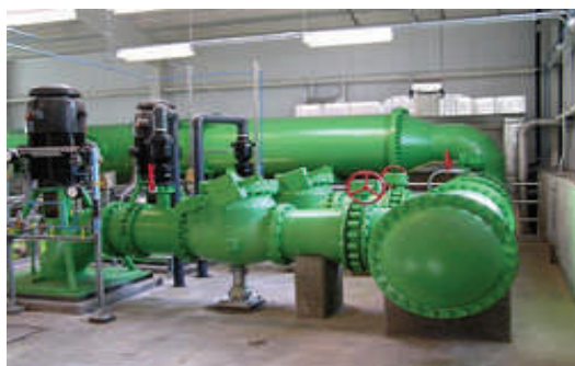
Сл.2.34.Пумпи во пумпна станица
