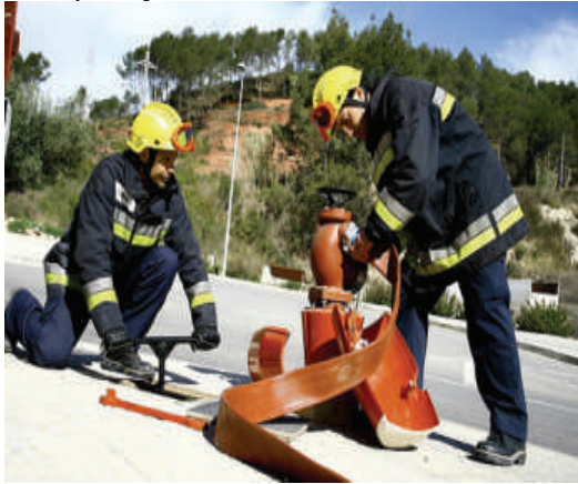
Сл.2.58. Активирање на противпожарен надземен хидрант
