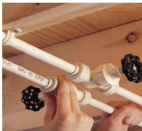
Сл.4.9.Разводна мрежа: а)основа на визба; б)пластични цевки под меѓукатна конструкција.
