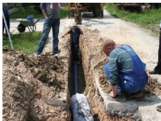
Сл.2.52.Поставување на цевки
