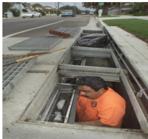
Сл.3.27.Уличен сливник, одржување
