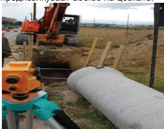
Сл. 3.13 Копање ров и поставување бетонска цевка со помош на геодетски инструмент
