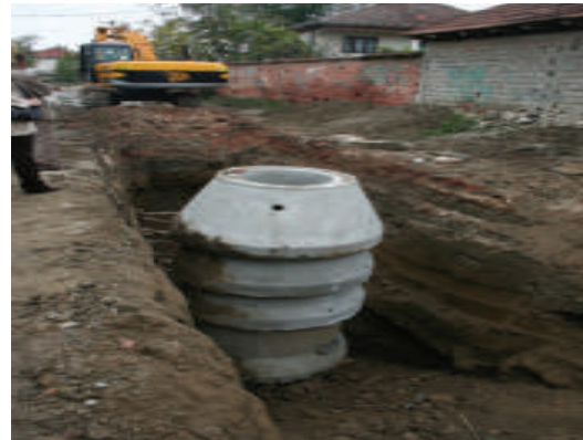
сл.3.18 Изведба на контролна/каскадна шахта од монтажни елементи
