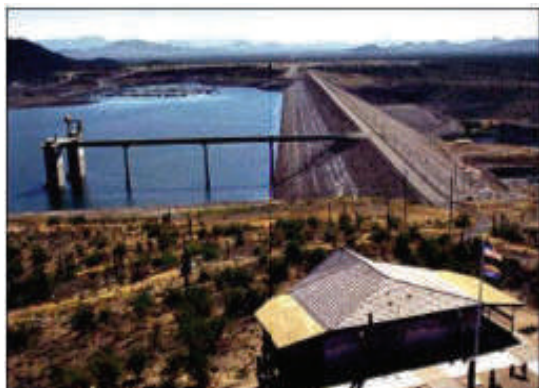
Сл.2.8.Кула водозафат во езеро
